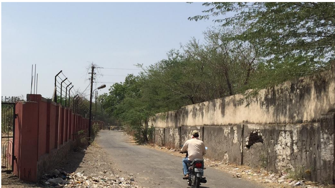
Img 10 : Undefined Road Edge
