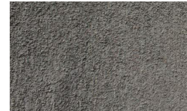
2.5.a : Walls External
