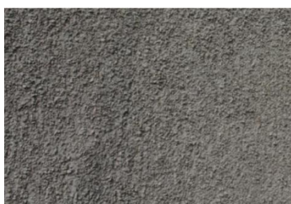
5.5.a : WALLS - EXTERNAL
