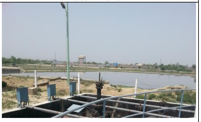
14 MLD WSP STP Kulu Ka Nagla
