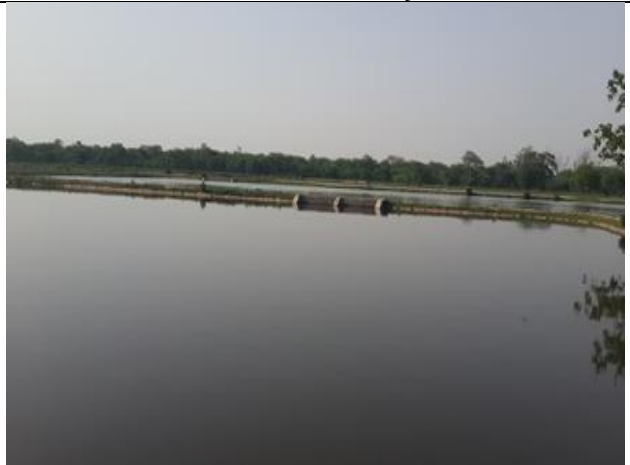
Masani STP - Stabilisation Pond
